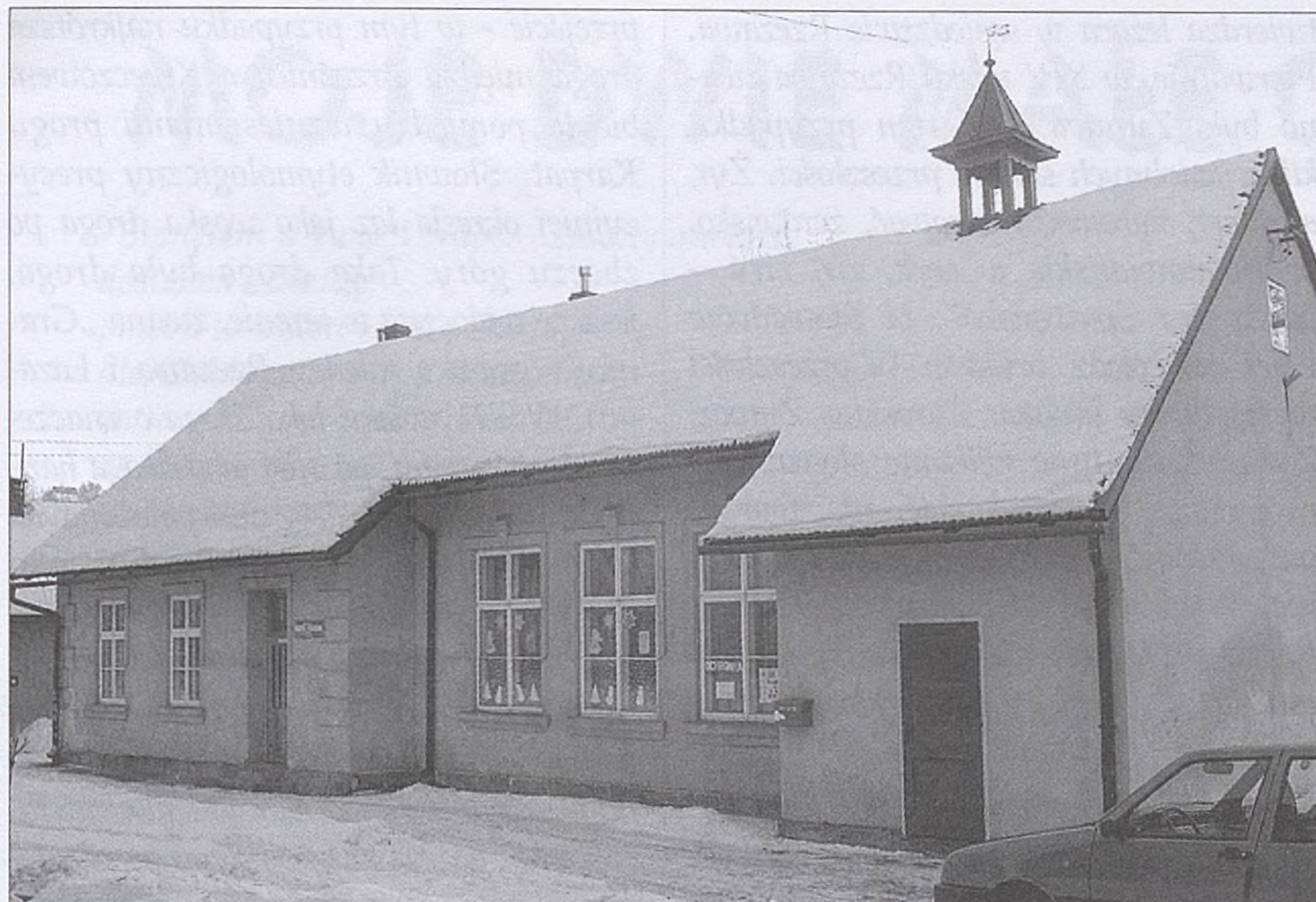
Budynek „Ochronki” i biblioteki w Dołuszcach. W bliskim sąsiedztwie znajduje się też remiza OSP.
