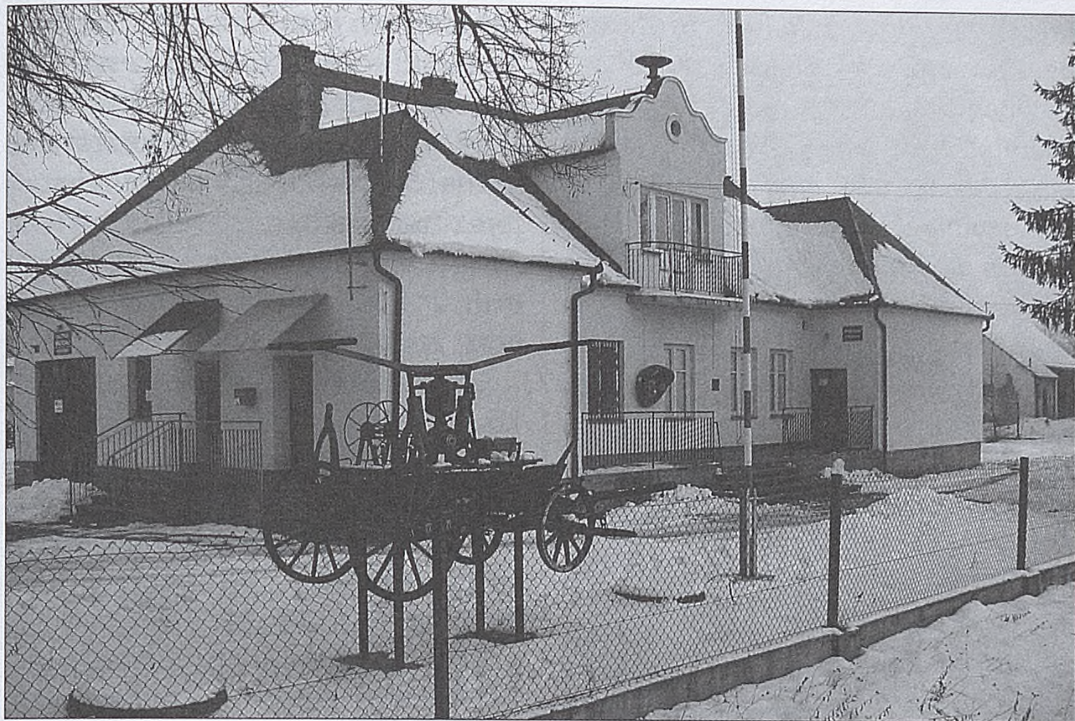
W centrum Baczkowa znajduje się m.in. budynek świetlicy i OSP, a także szkoła i kaplica.
