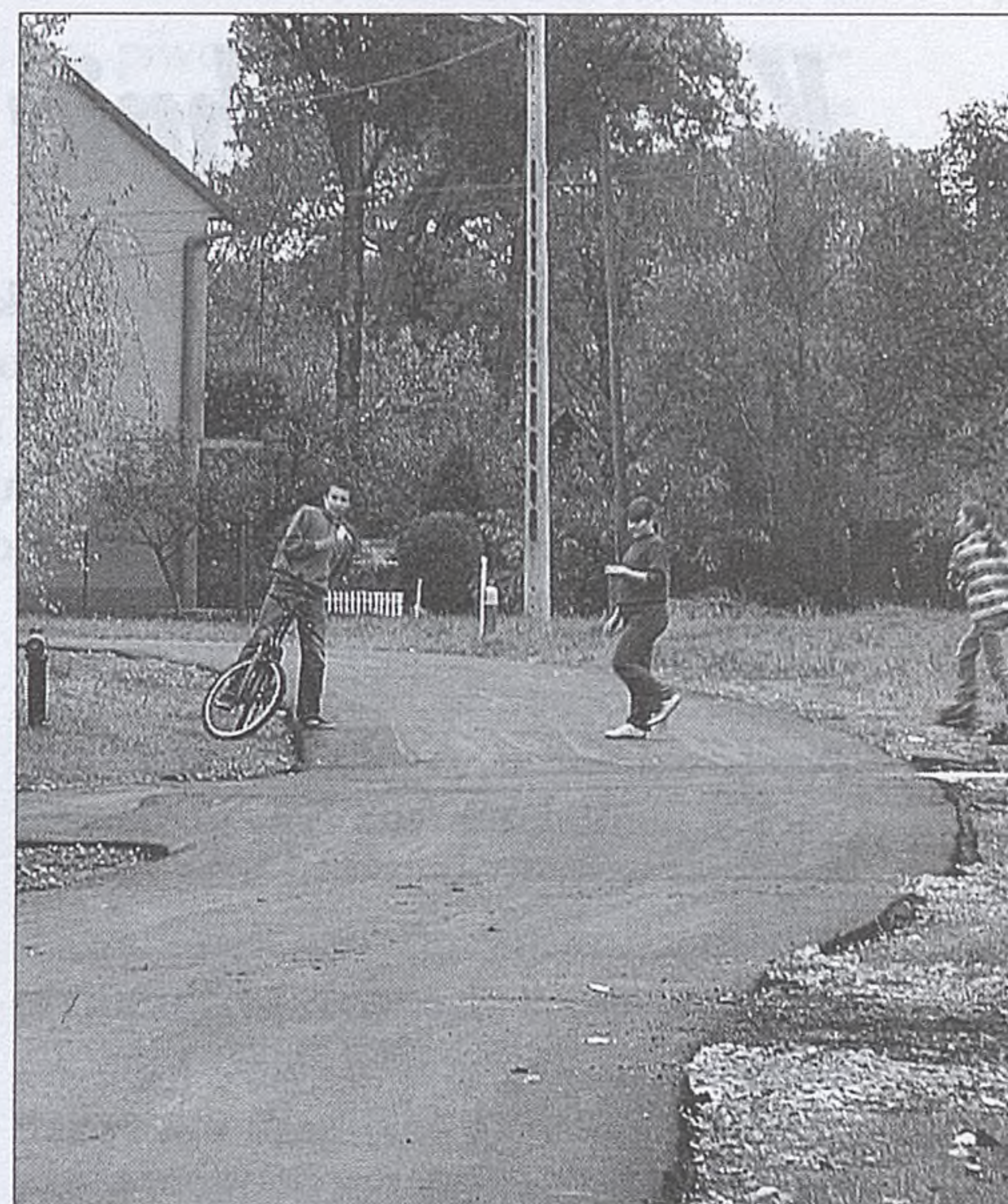
Jedna z ostatnich inwestycji w Krzczowie – 900 metrów asfaltowej drogi.
