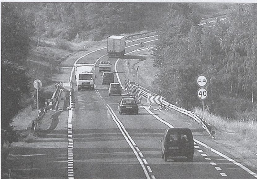
Na razie na moście sztucznie zawężono przejazd oraz postawiono znaki nakazujące ograniczenie w tym miejscu prędkości do 40 km/h i zakaz wyprzedzania.
