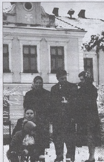
Budynek szkoły w latach międzywojennych XX w. fot. arch. szkoły
