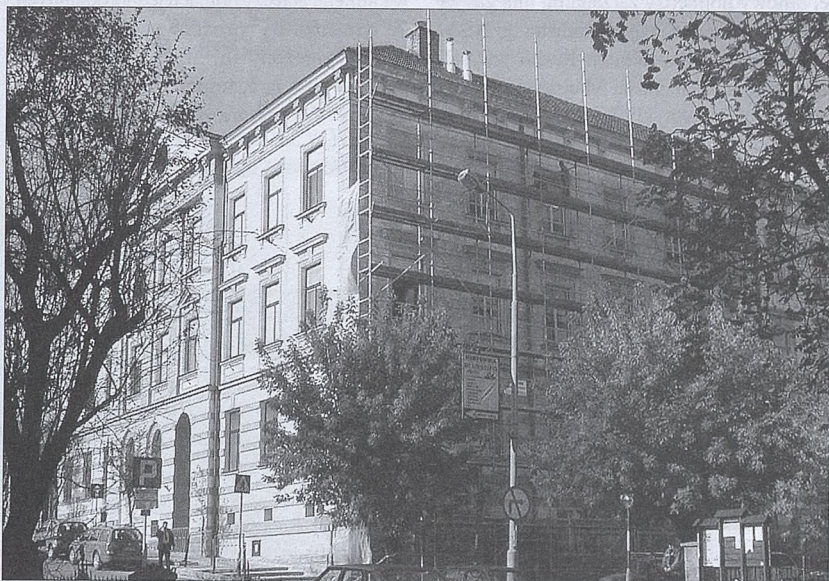
Trwają prace nad odnowieniem elewacji na budynku Gimnazjum nr 1.
