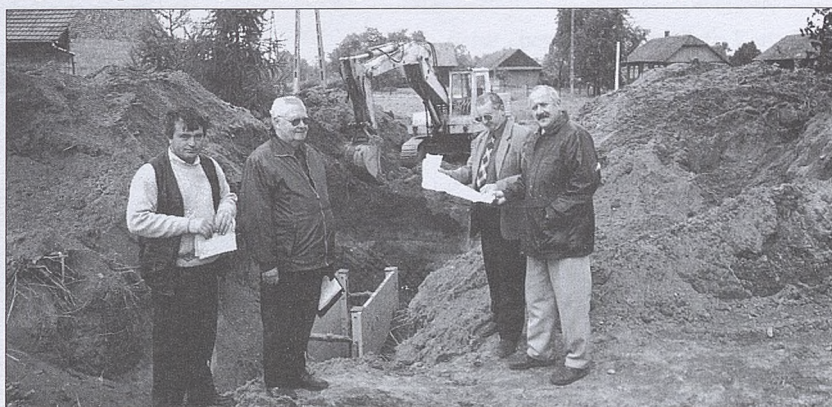
Księżycowy krajobraz z placu budowy. Od lewej: wykonawca – Czesław Ciszewski, inspektor nadzoru – Jerzy Radliński, przyszły administrator sieci – Tadeusz Chyla i wójt gminy – Jerzy Lysy.
