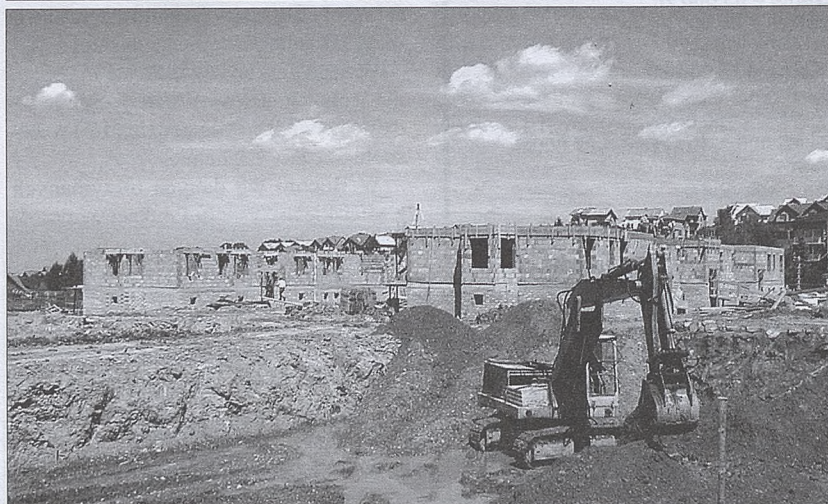
Budowane przez właścicieli firmy „Mag” osiedle przy ul. Brzeźnickiej
