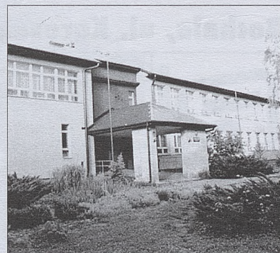
Szkołę w Bogucicach już wyremontowano, kotłownia czeka na modernizację...
