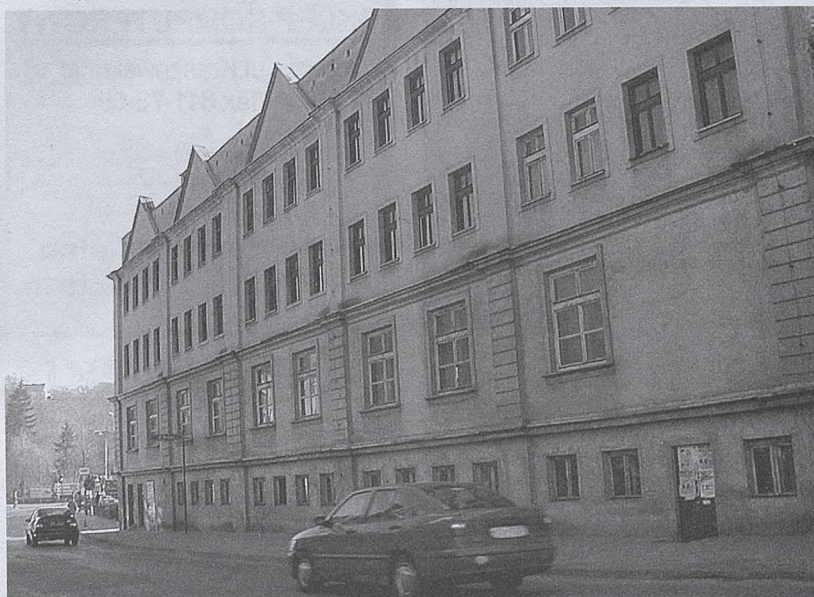
Kopalniany budynek przy ul. Kraszewskiego.
