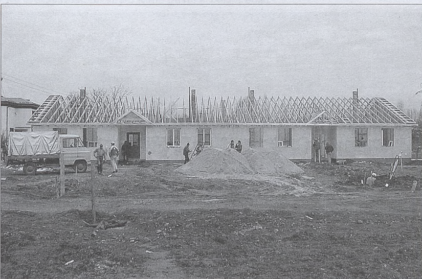
Przy ul. Wygoda boczna w rekordowym tempie powstają budynki, w których mieścić się będą mieszkania socjalne. Swoją dom będzie miało 18 rodzin.
