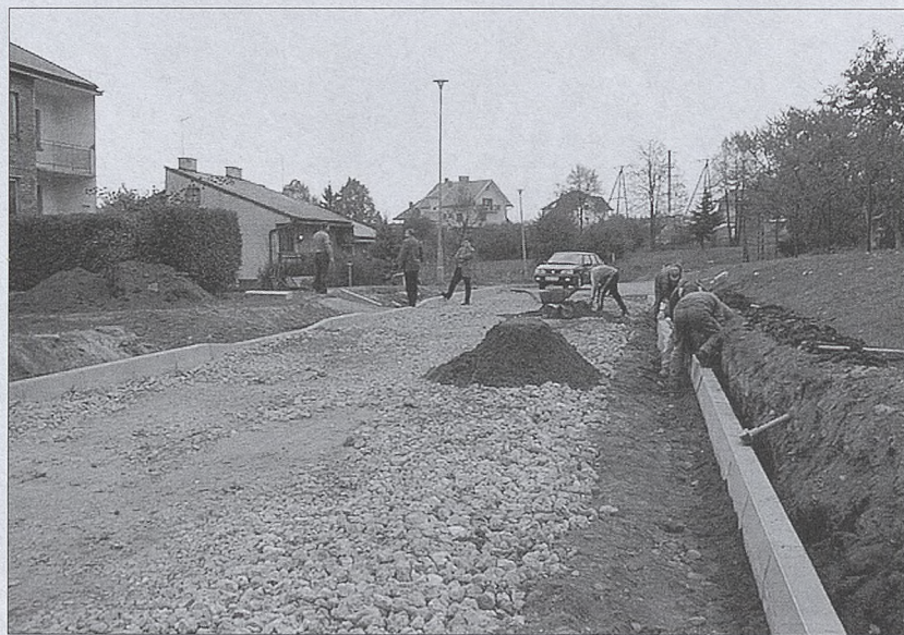
Roboty na ul. Podgórcza.
