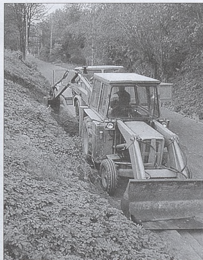
Budowa chodnika na ulicy Konfederatów Barskich.
