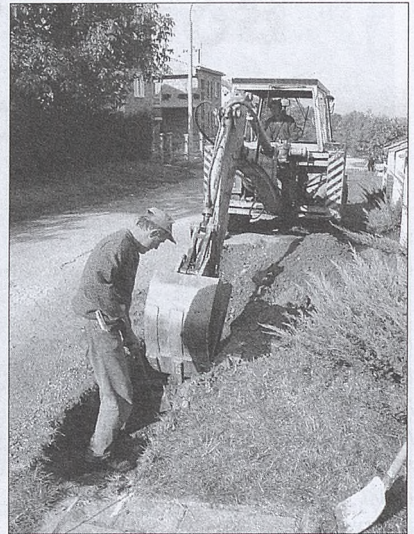
Budowa kanalizacji na os. Krzęczków
