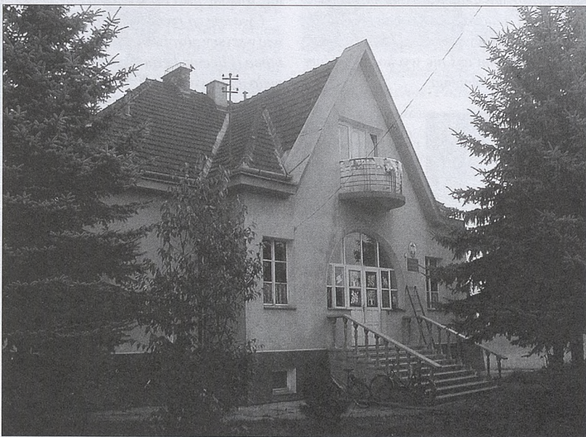
Budynek Szkoły Podstawowej w Cikowicach.
