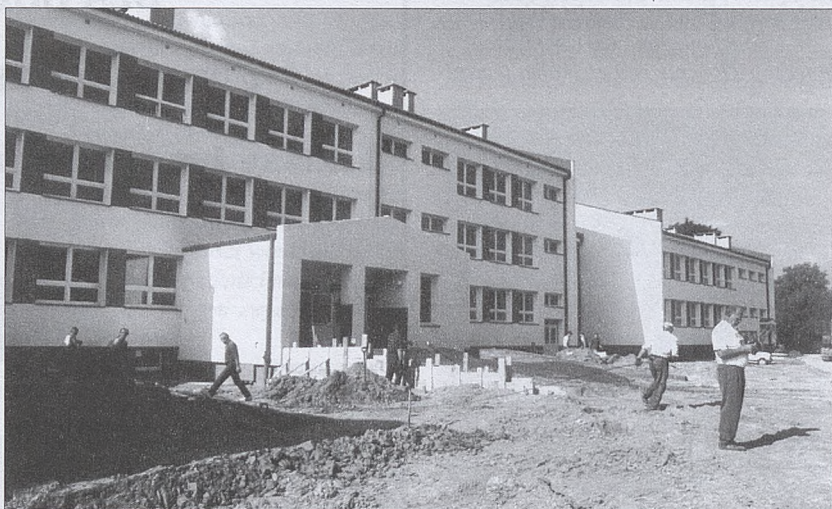
Na kilka dni przed rozpoczęciem nauki trwają ostatnie prace wykończeniowe i nad zagospodarowaniem terenu
