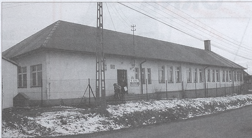
Budynek Szkoły w Dąbrowicy. Już niedługo otwarta zostanie tutaj nowa sala gimnastyczna.
