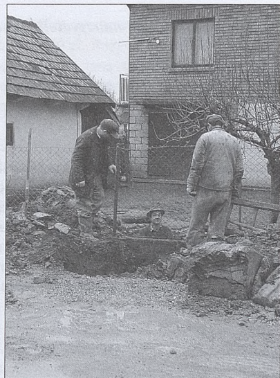
Wykonanie przyłącza kanalizacyjnego przy ul. Smyków.
