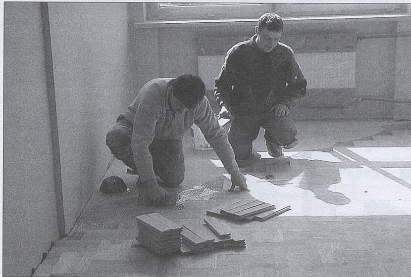
W szkole na os. św. Jana trwają prace posadzkarskie.
