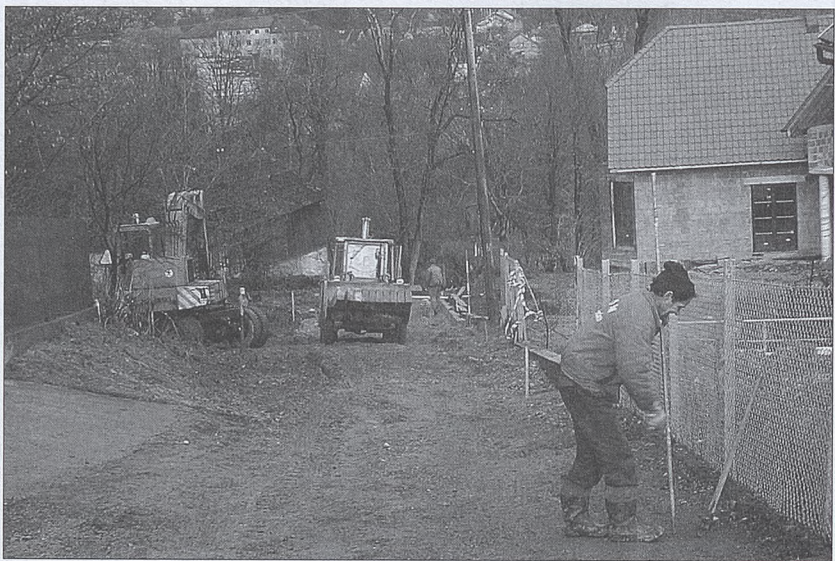
Budowa drogi przy ul. Uzbornia.
