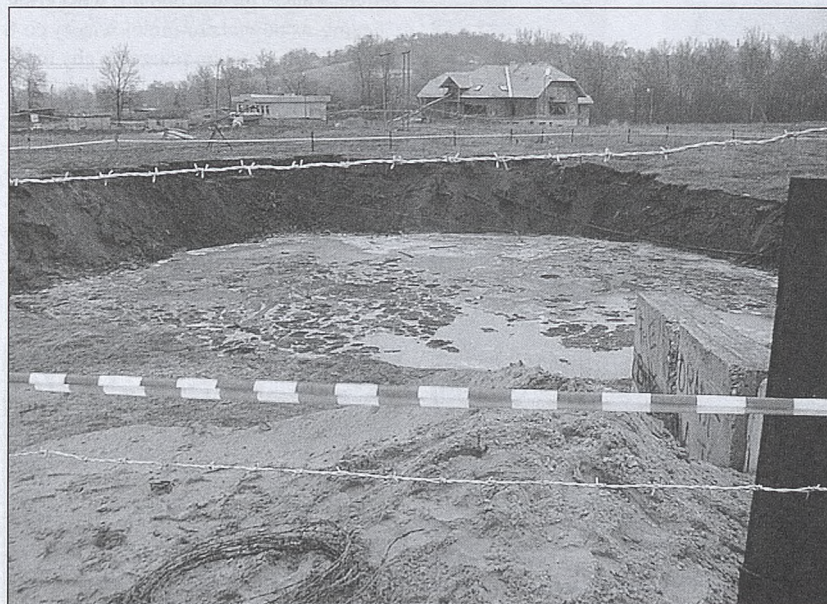
Powstałe w Łęzkowicach zapadlisko ma 60m średnicy i 68m głębokości.
