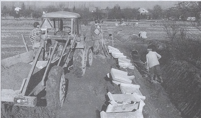
Prace przy rowach na ul. Karasia w Bochni
