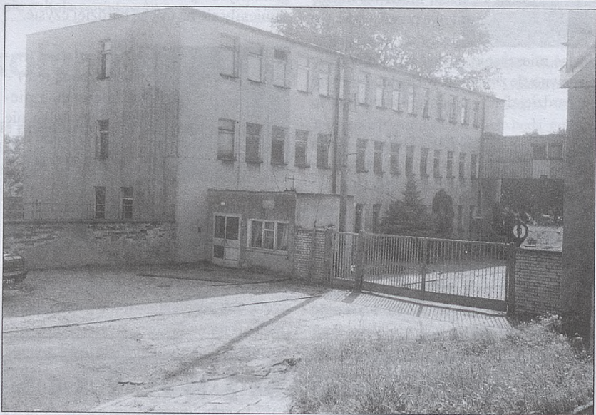
Dawny budynek administracyjno-socjalny przed remontem...
