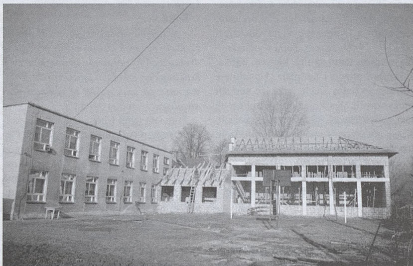
Mimo zimy trwają prace budowlane przy sali gimnastycznej.
