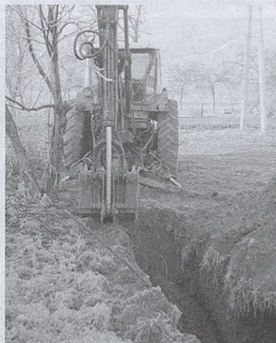
Ekipa z Proszowic jest wykonawcą „Wodociągu – Północ”.
