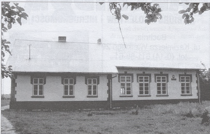
Szkoła w Ostrowie Szlacheckim – od ubiegłego roku wygląda jak nowa
