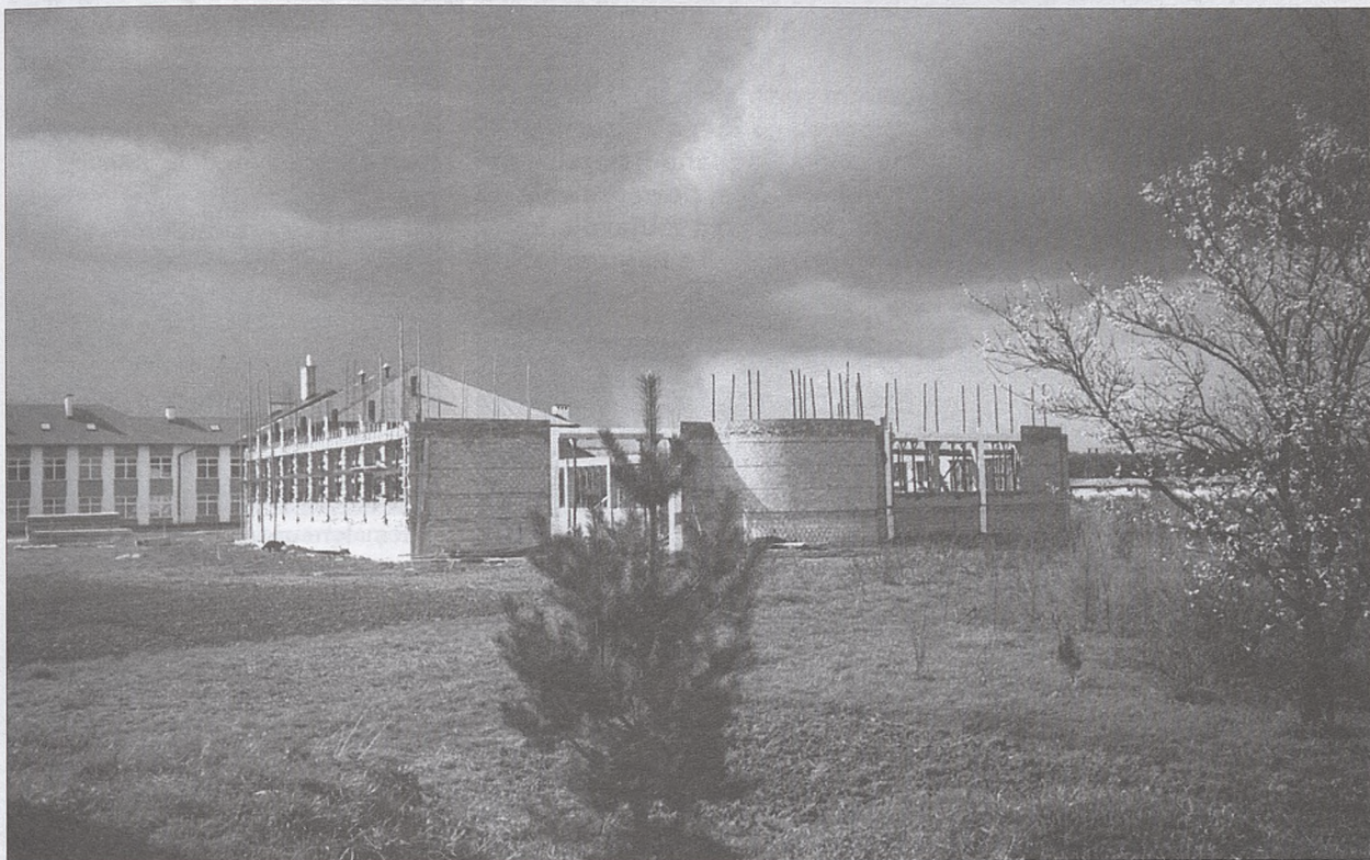
Budowany w Proszówkach metodą tradycyjną. Koszt – 3.100.000 zł.
