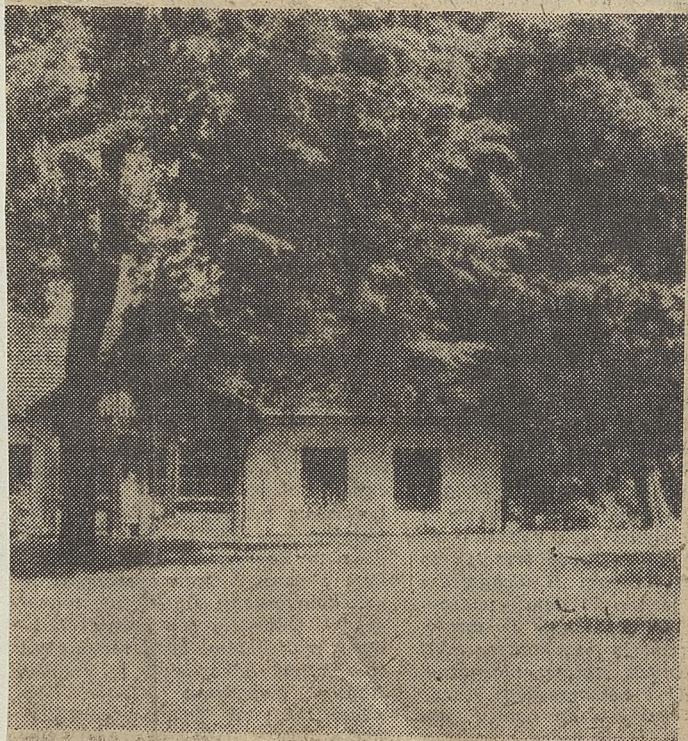
— widok od strony południowej
