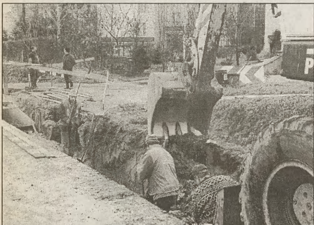
Trwają roboty na Królowej Jadwigi.
