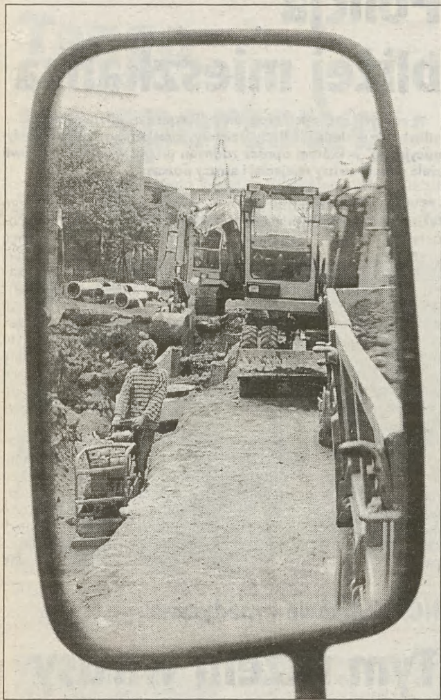
Trwają prace kanalizacyjne na ul. Skotnickiej
