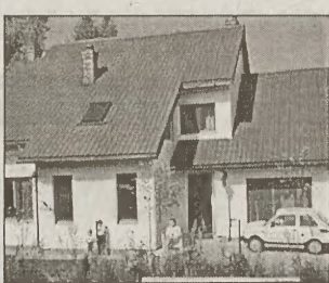
KRYNICA Reymonta, 160m 2 , nowy, 320.000zł do neg. „Property” 018/4437380, 5480606.
