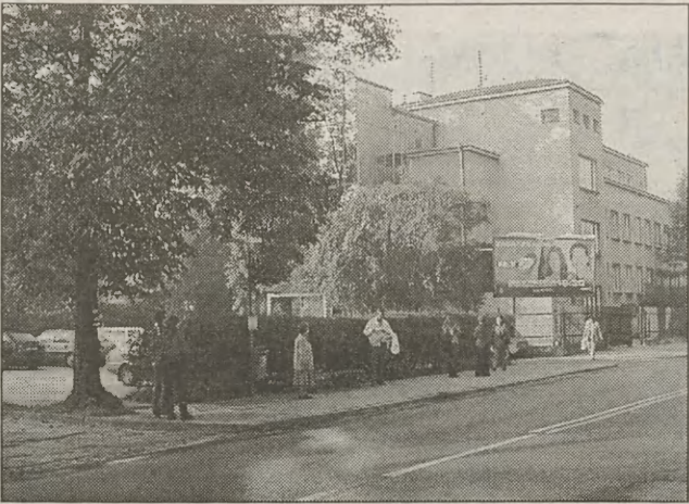
Zgody na postawienie wiaty nie wydano, ponieważ teren, na którym miałaby stanąć jest silnie uzbrojony
