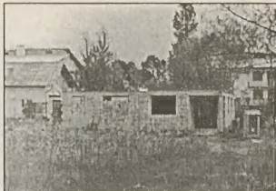
ŚWINIARSKO, rozpoczęła budowa, 1 płyta, 65.000zł, dz. 7ar. „Property” 018/4437380, 5480606.
