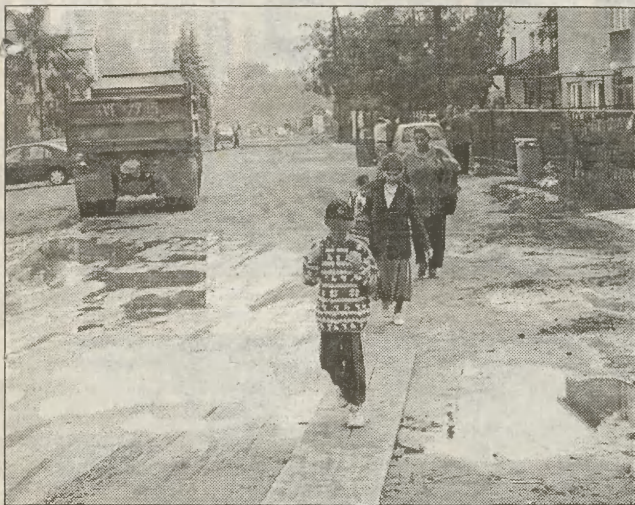
Trwają roboty kanalizacyjne na Strąkowej
