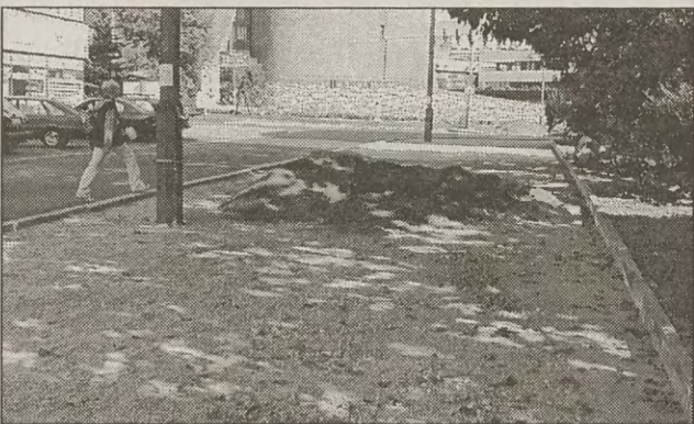
Trwa remont chodnika przy ul. Szajnowicza. Na terenie Bieńczyk wyremontowane zostaną jeszcze chodniki przy ul. Złoczowskiej, w os. Strusia, Złotej Jesieni, Jagiellońskim, Kazimierzowskim i wzdłuż ulicy Urbanowicza
