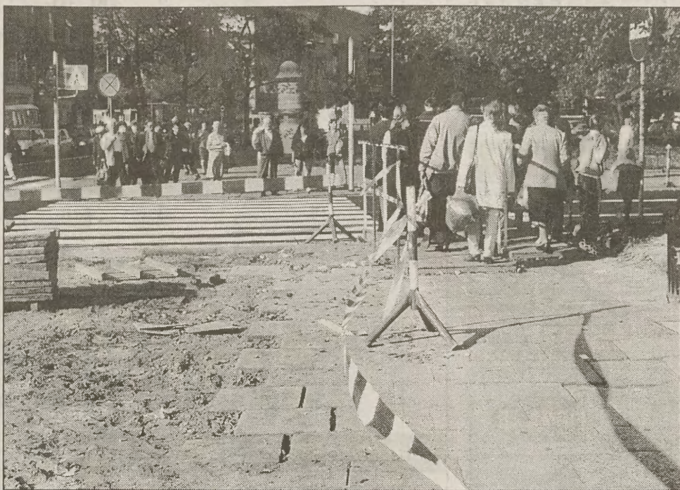
Przebudowa al. Słowackiego utrudnia życie kierowcom i pieszym
