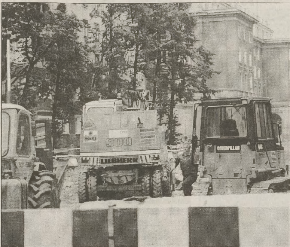
Trwają roboty związane z modernizacją al. Róż
