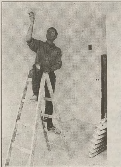
W „Atolu” na Grochowej trwa remont
