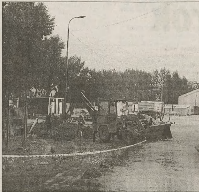
Na giełdzie przy ul. Balickiej już rozpoczęły się prace
