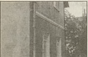
Dąbrowa Tarnowska -centrum, murowany 75 m 2 (2p, k, ł), stan techniczny dobry, 33.000 zł. „Consulting” (0-14)627-56-40, 0621-68-08, 0602-725-783.
