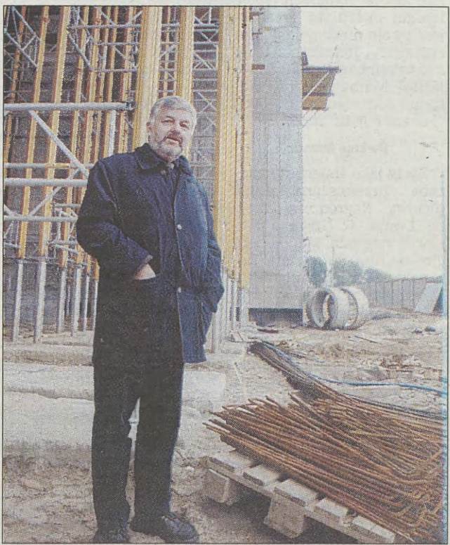
— Projekt wymagał zastosowania specjalnego systemu stawiania ścian. W Krakowie wykorzystano go dopiero kilka razy — mówi Mieczysław Darlak, kierownik budowy.
