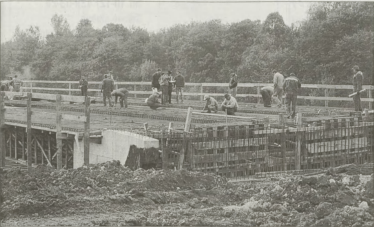
Do końca listopada potrwają prace nad doprowadzeniem ul. Witosa do sanktuarium w Łagiewnikach
