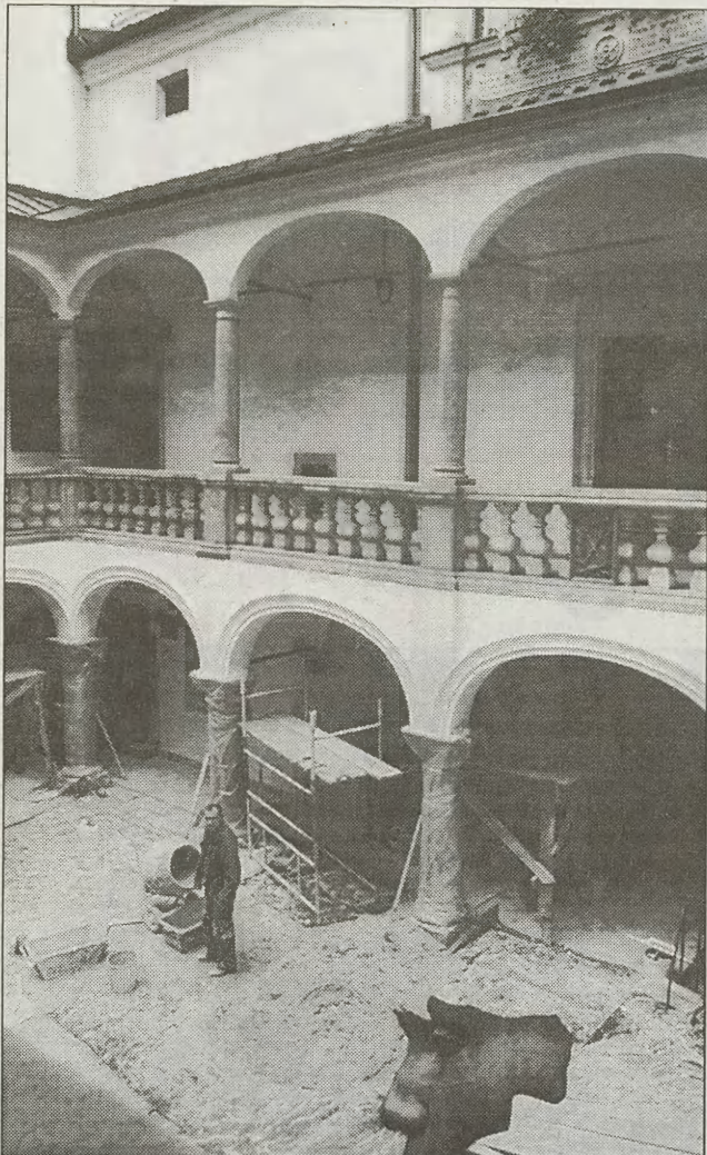
Trwa remont dziedzina Collegium Iuridicum przy ul. Grodzkiej
