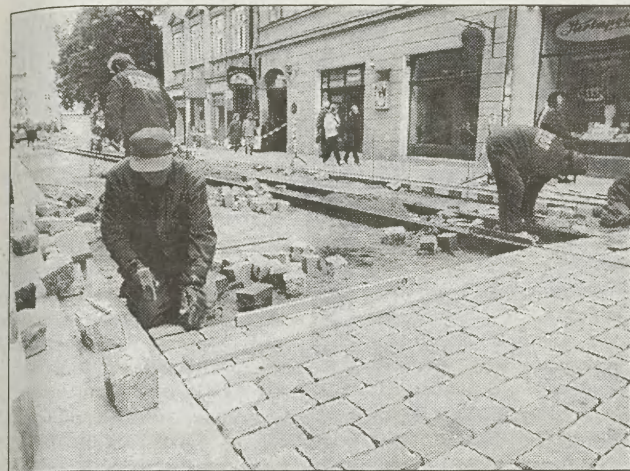
Wczoraj rozpoczęto układanie nowego bruku na remontowanej ulicy Szewskiej.
