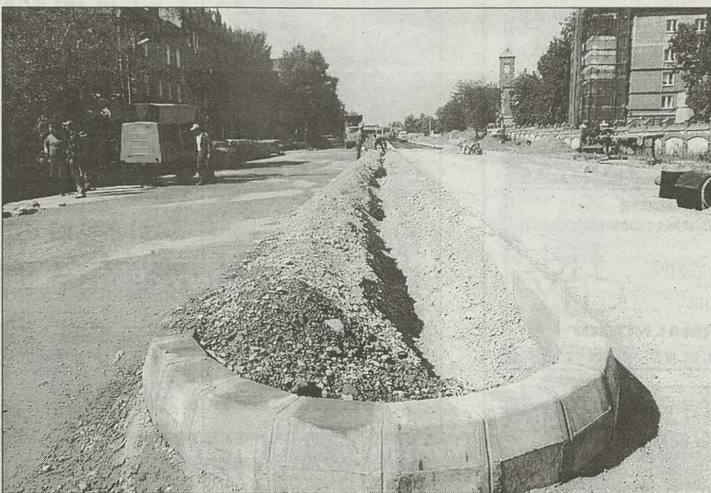
Budowa ulicy Lubomirskiego potrwa do końca roku
