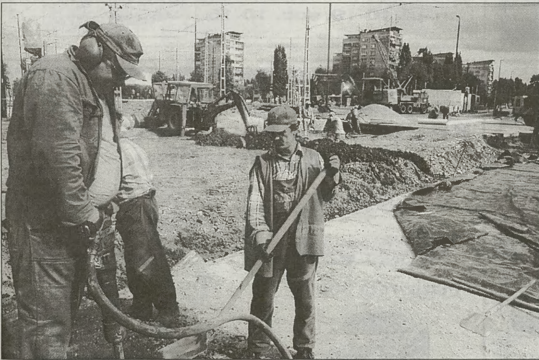
Trwają prace związane z przebudową torowiska na rondzie Czyżyńskim
