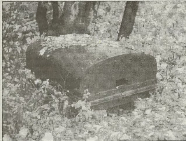
Prawdopodobną rzadkością jest zachowana w forcie 51 „Rajsko” obserwacyjna kopuła pancerna
