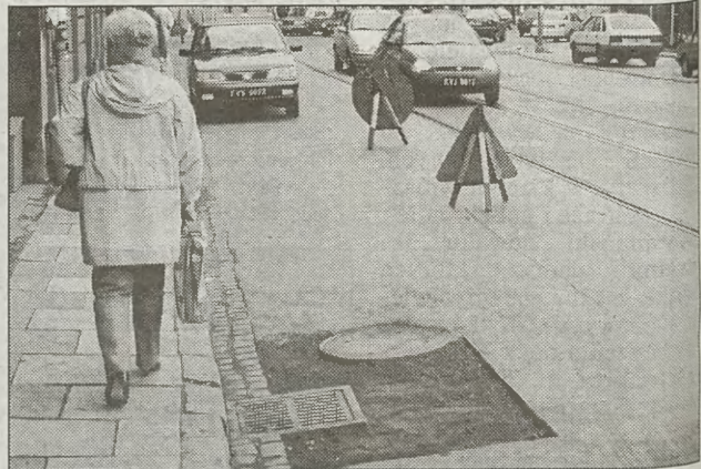
Kierowcy przejeżdżający dziś przez ul. Kalwaryjską powinni zachować szczególną ostrożność na wysokości ul. Słiskiej. Wciąż widać tam efekty pracy robotników układających pod jezdnią nowe przewody światłowodowe.
