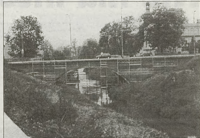
Z mostu na Rudawie znikną metalowe poręcze, a zastąpią je eleganckie murki, obłożone piaskowcem Fot. Monika CHYLASZEK
