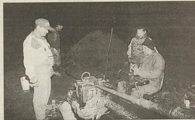
Do późnych godzin wieczornych pracownicy Krakowskiego Zakładu Wykonawstwa Sieci Elektrycznych dokonywali we wtorek sterowanego przewiertu pod jezdnią, łączącą Balice z węzłem w Opatkowicach.
