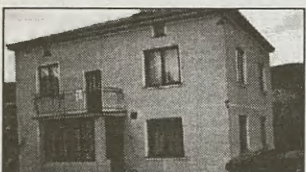
m 2 (6p, k, 2ł), z 1980 r., niezamieszany w dobrym stanie technicznym, działka 1 ha, dodatkowo dom drewniany 60 m 2 , 125.000 zł. „Consulting” (0-14)627-56-40, 0602-725-783.
