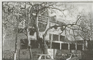
N.Sącz, ul.Żeromskiego -budynek stan surowy, otwarty, pow. 794 m 2 . Wynajem lub sprzedaż. Agencja (0-18)442-31-48
