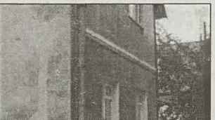
Dąbrowa Tarnowska -centrum, murowany 75 m 2 (2p, k, ł), stan techniczny dobry, 33.000 zł. „Consulting” (0-14)627-56-40, 621-68-08, 0602-725-783.
