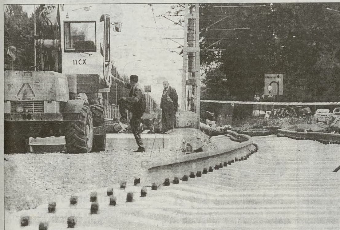
Na rondzie Czyżyńskim położono podkłady pod nowe torowisko
