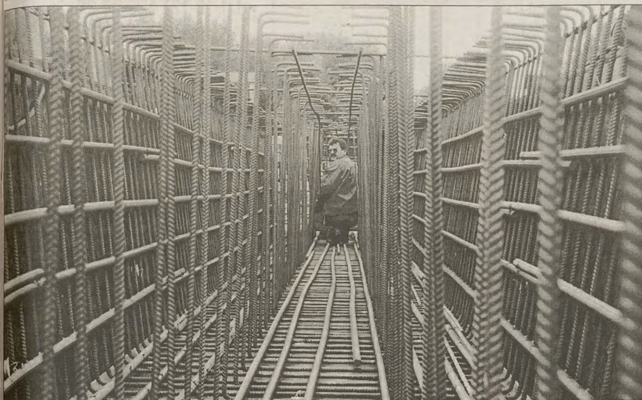
Szybko posuwają się prace związane z przedłużeniem ul. Witosa do Łagiewnickiego sanktuarium
