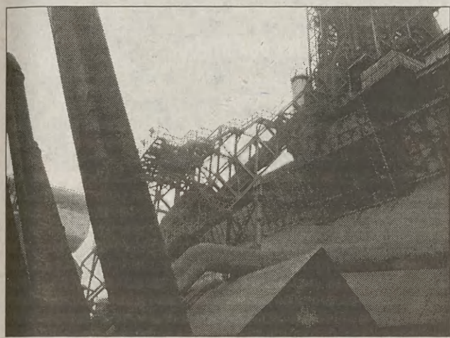
Widok wielkiego pieca od strony wsadu. Kolejno podjeżdżają wagoniki z rudą.
