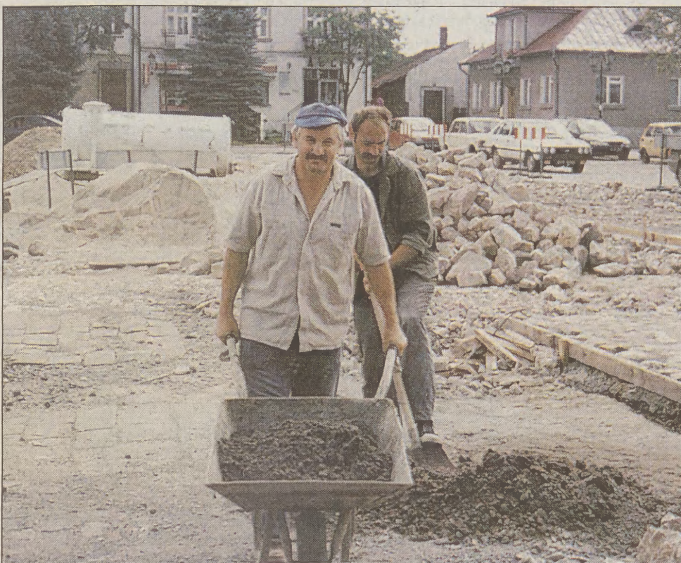
Do końca roku powinny się zakończyć prace modernizacyjne nawierzchni Rynku
