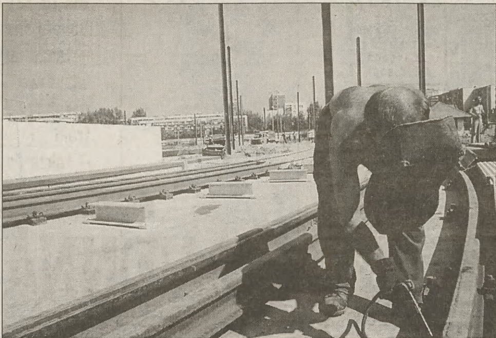
Trwają prace wykończeniowe na pętli szybkiego tramwaju w Kurdwanowie
