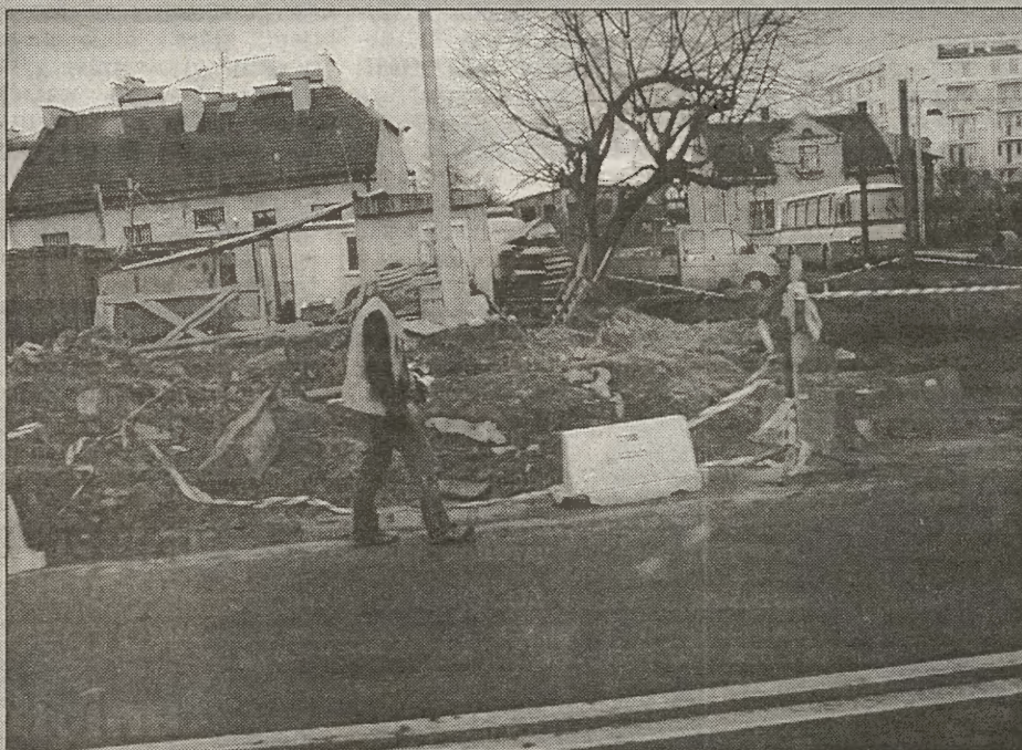
Część ulicy i pobocze na 29 Listopada zajęła ekipa prowadząca roboty kanalizacyjne
