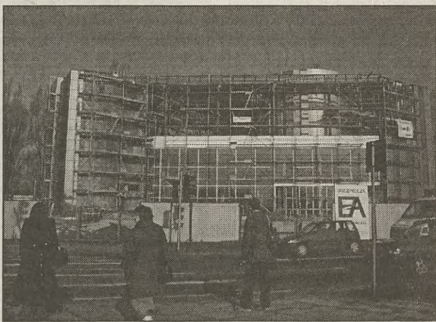
Tereny wokół ronda Ofiar Katynia są niezwykle atrakcyjne dla inwestorów. Działają tu Makro Cash and Carry, IKEA, swe biura otworzyły niedawno Wielkopolski Bank Kredytowy SA, Netia i Impol. Trwa budowa wielkiego salonu samochodowego
