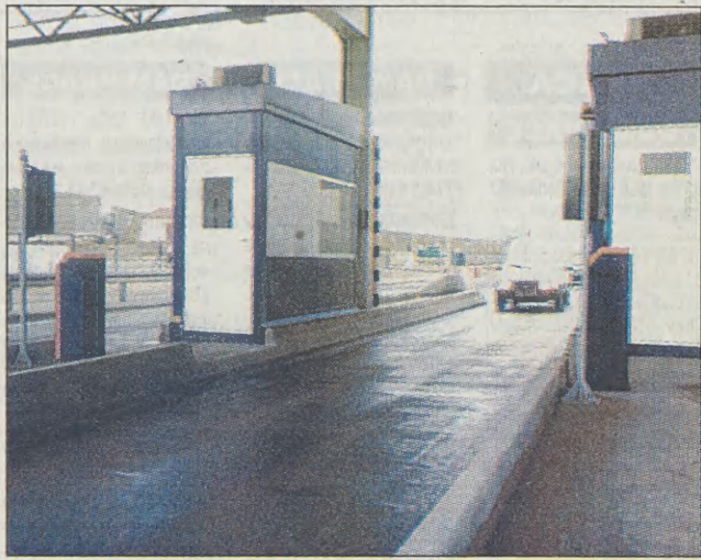
W podkrakowskich Balicach twają testy systemu pobierania opłat. Nadal nie ma orzeczenia w sprawie własności części działki, na której wybudowano roгатki.
