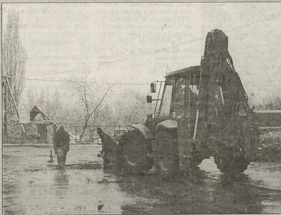
Mimo deszczowej pogody w sobotę na ulicy Skrzyneckiego pojawili się robotnicy, którzy naprawiali jezdnię
