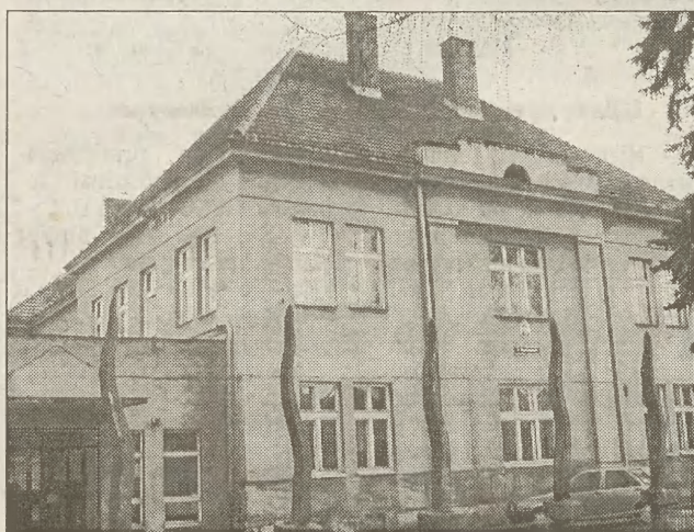
Wkrótce ten budynek będzie za ciasny
