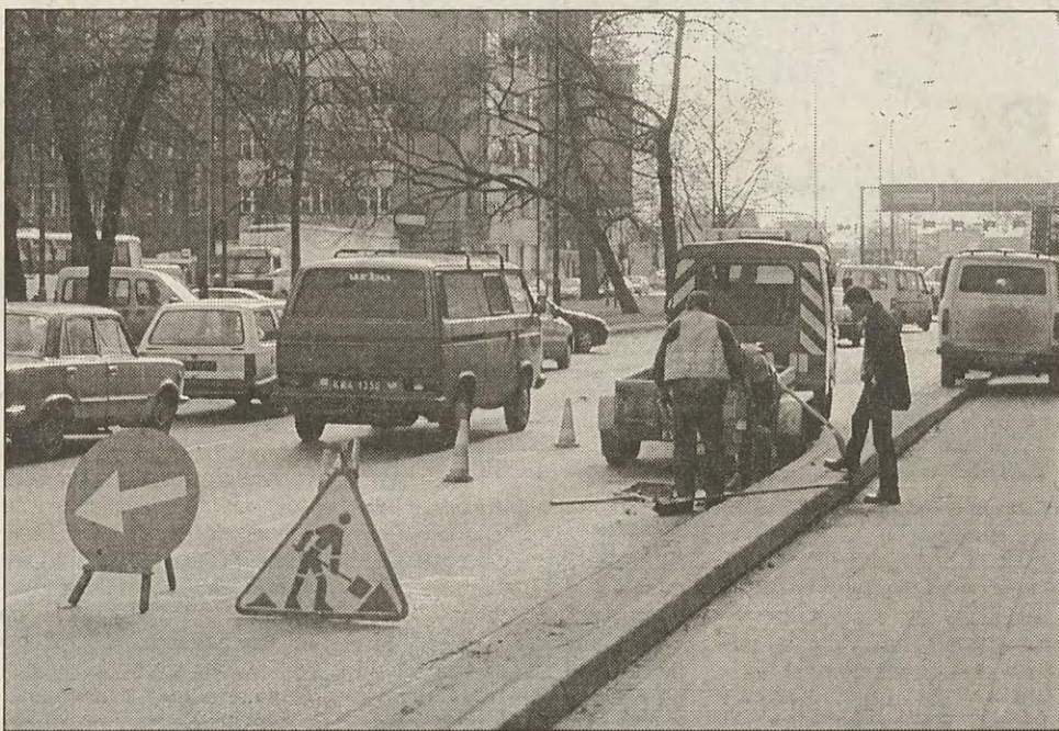
Tylko na jeden dzień ulewne deszcze wstrzymały pracę związane z naprawą nawierzchni krakowskich dróg. Wczoraj znowu ekipy remontujące jezdnie utrudniały ruch. Na zdjęciu zwężone aleje Trzech Wieszców
