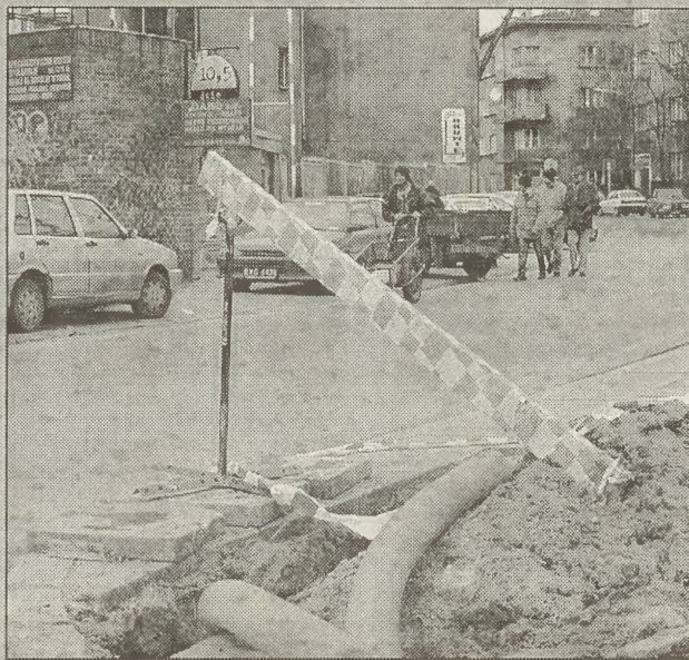
Wykopy na św. Łazarza-wciąż mogą utrudniać ruch pieszy
