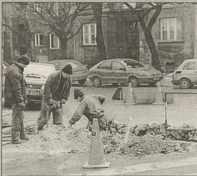
Bardzo sprawnie przebiegały roboty drogowe na ul. Dunina-Wąsowicza
