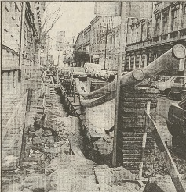
Na ul. Kochanowskiego rozkopane chodniki wciąż ograniczają ruch pieszy Fot. Adam WOJNAR
