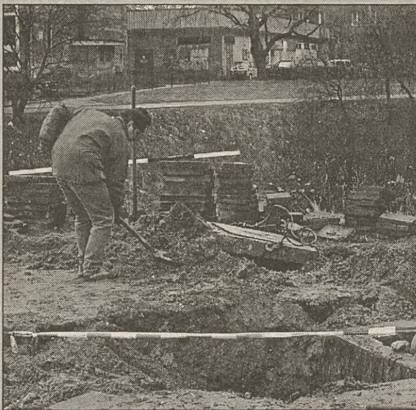
Najprawdopodobniej już jutro znikną z ul. Olszyny robotnicy układający kabel teletechniczny
