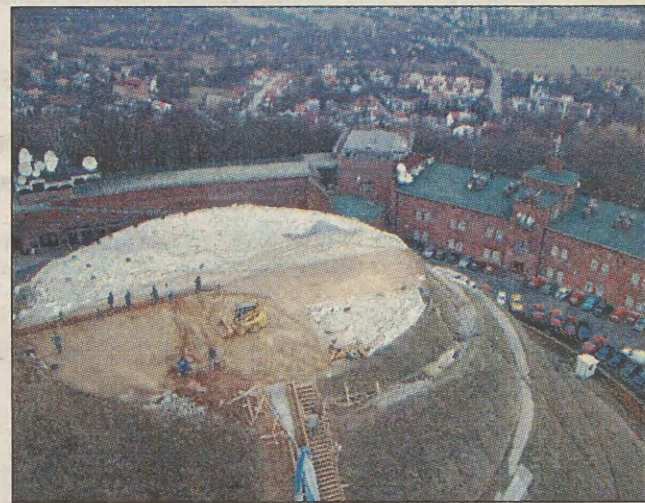
Widok kopca Kościuszki z montowanego właśnie dźwigu
