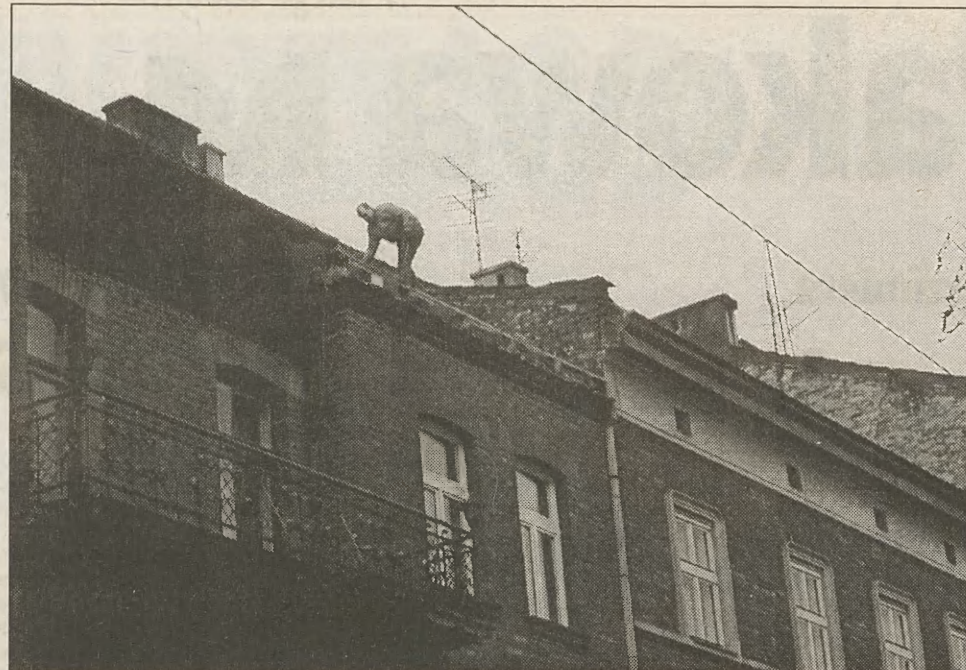
Właściciele i administratorzy kamienic wykorzystują sprzyjające ostatnio warunki pogodowe na dokonywanie niezbędnych napraw dachów i elewacji budynków. Na zdjęciu: prace na dachu jednej z kamienic przy ul. Lelewela-Borelowskiego (pk) Fot. Przemysław KOCUR
