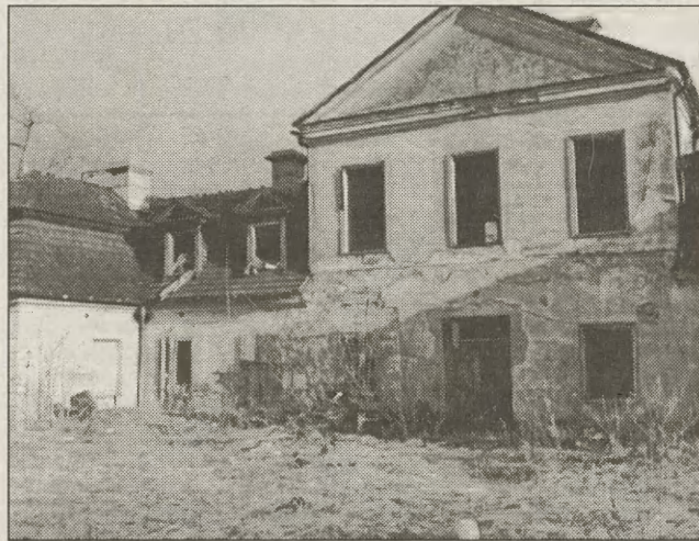
Zabytkowy budynek z XVIII w. niszczeje coraz bardziej
