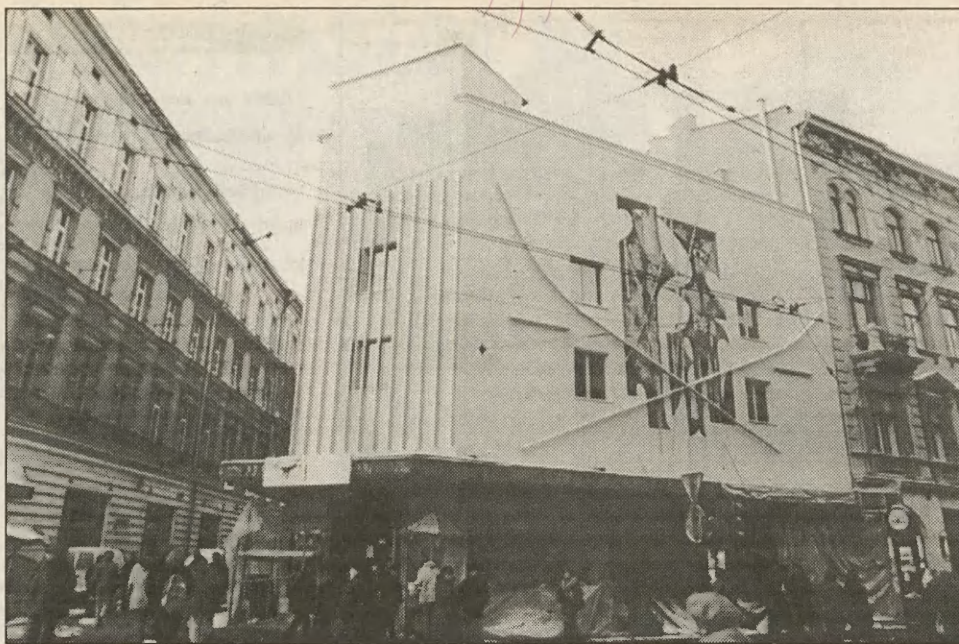
Nowe szaty teatru Bagatela. Powoli — choć remont jeszcze nie został zakończony — wylaniają się odnowione ściany budynku (AW), Fot. Adam WOJNAR
