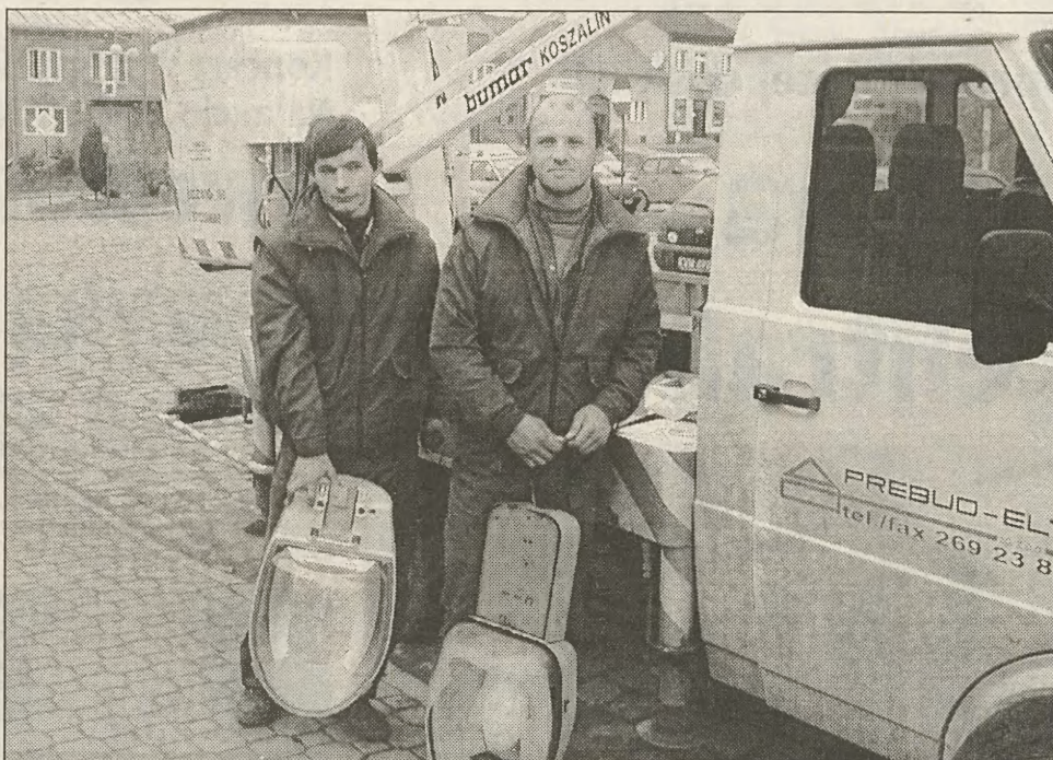
Kiedy pod koniec ubiegłego roku montowano w Słomnikach nowe latarnie, nikt nie podejrzewał, że przysporzą one radnym tyłu kłopotów
