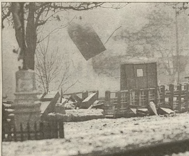
Wczoraj rano w Warszawie został wysadzony przez saperów wiadukt na ul. Polczyńskiej. W tym miejscu ma być wybudowany nowy. Fot. CAF
